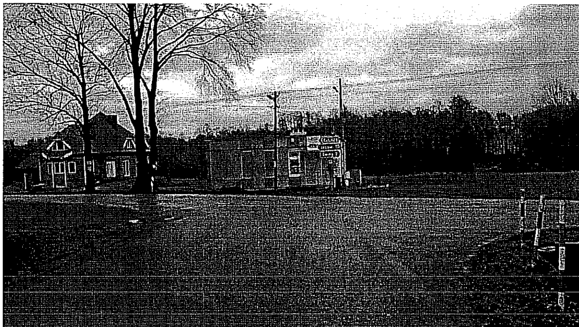
Fot. 1 Skrzyżowanie dróg powiatowej Nr 2918E oraz drogi gminnej Nr 106254E.
