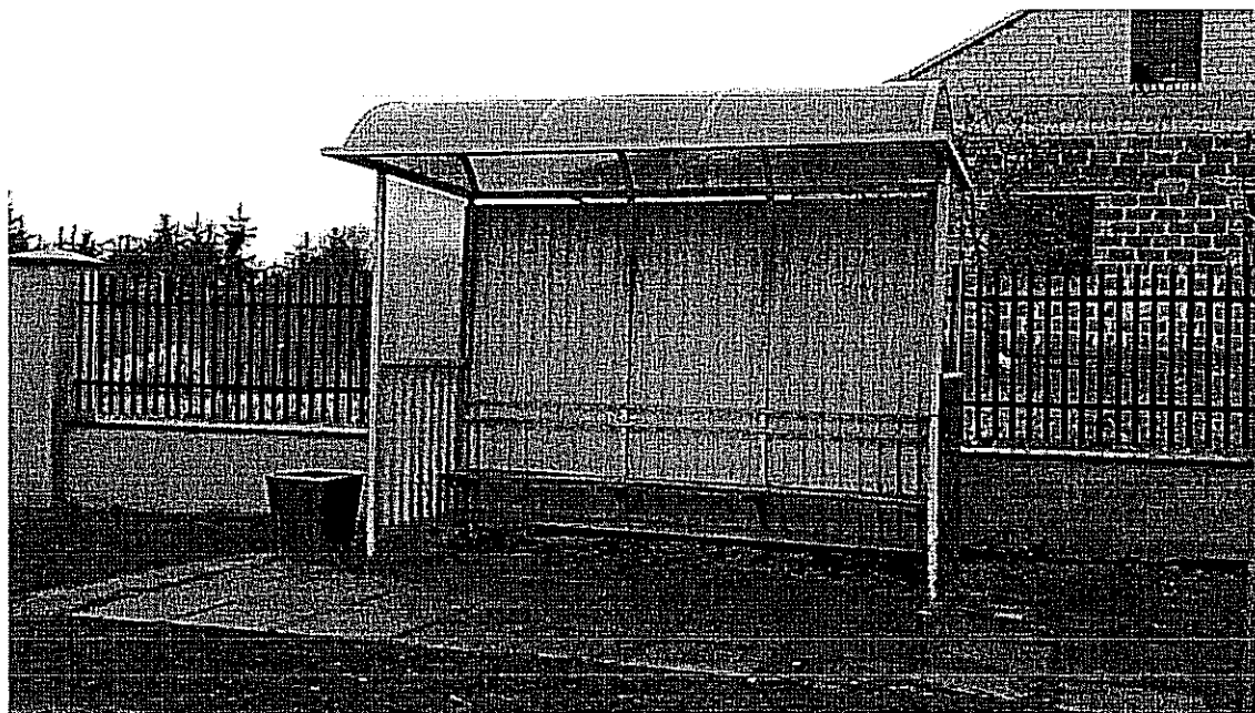
Fot. 13. Wiata przystankowa dla dzieci przy drodze gminnej w Wierzchach.
