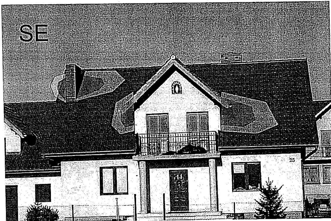
Rysunek 7 Strefy zacieniania na dachu skierowanym na południowy wschód
