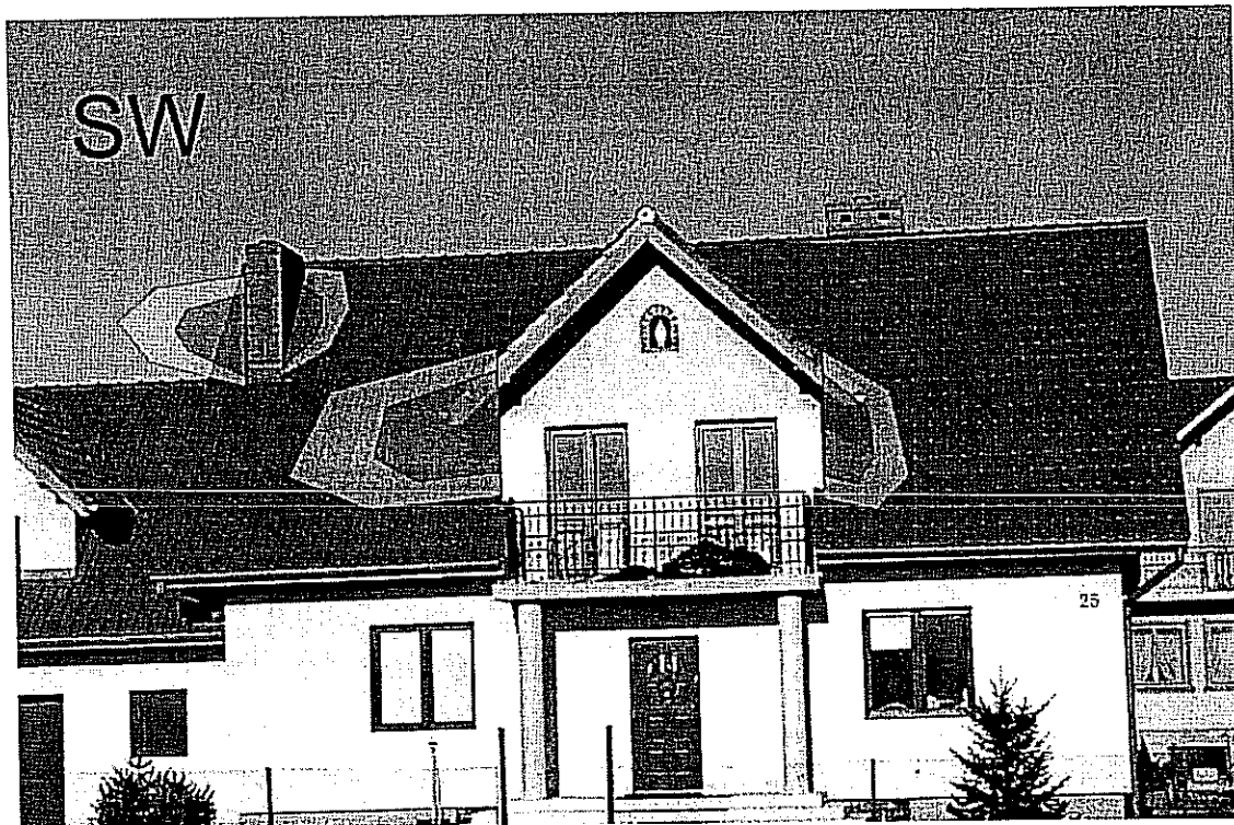
Rysunek 8 Strefy zacieniania na dachu skierowanym na południowy zachód
