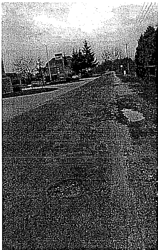
Fot. 7 i 8 Nawierzchnia drogi gminnej Nr 106261E w Zyguntowie, widoczne liczne spękania i ubytki nawierzchni.
