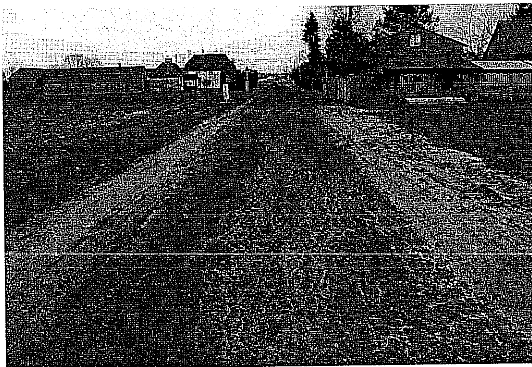
Fot. 13. Aktualny stan nawierzchni ul. Strażackiej
